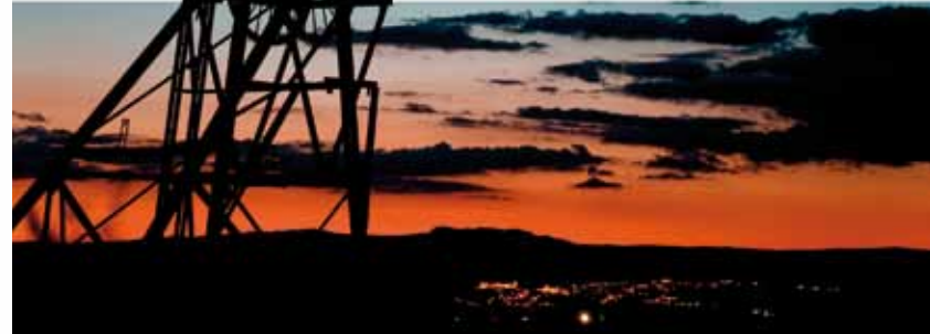
Cabria de la Mina San Francisco. Al fondo, Baños de la Encina.
