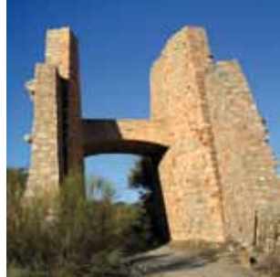
En las dos imágenes, pozo y paso elevado de la mina de San Andrés.
